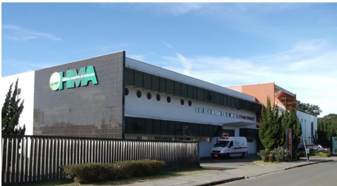
Figura 68: Equipamento de Saúde na AIA: Hospital Municipal de Araucária
