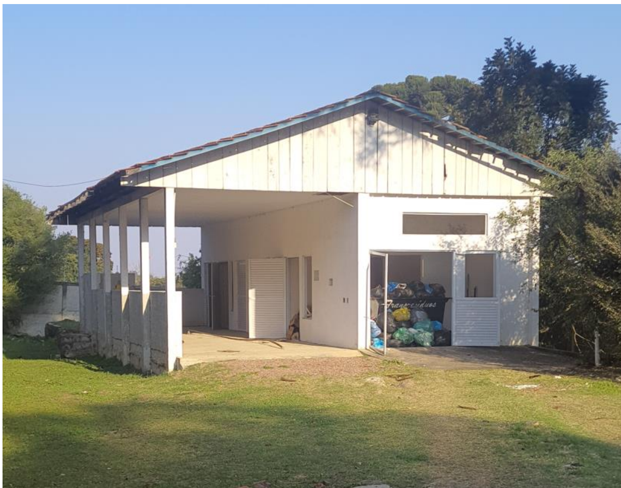
Figura 15: Foto do bloco de armazenamento de resíduos
