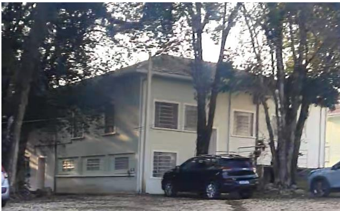
Figura 12: Foto do Bloco 02
