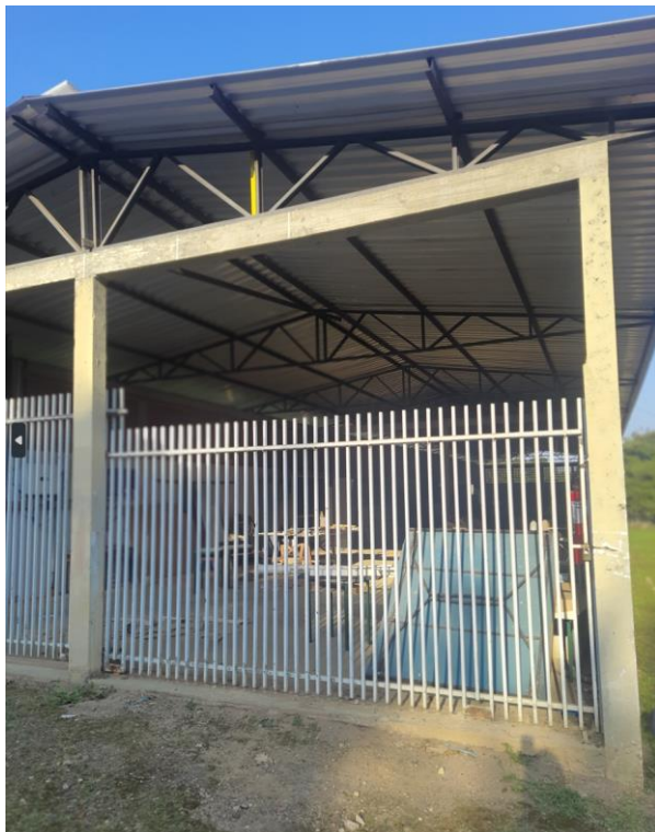
Figura 14: Foto do bloco 4 - Depósito
