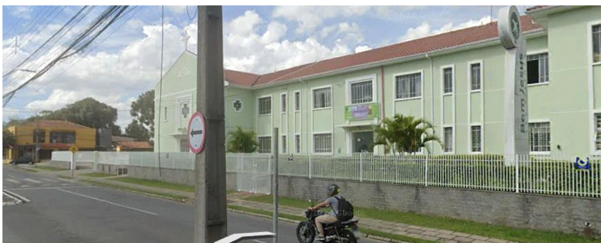
Figura 53: fachada do imóvel mostrando altura do bloco 1 e do muro de divisa.
