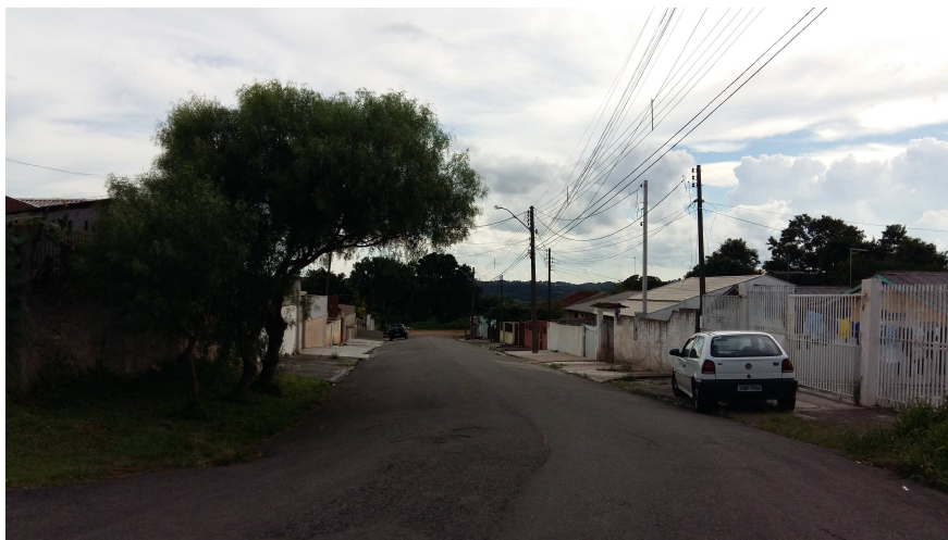
Figura 14: Rede de energia elétrica e falta de iluminação pública na Rua Amazonas que dá acesso ao empreendimento
