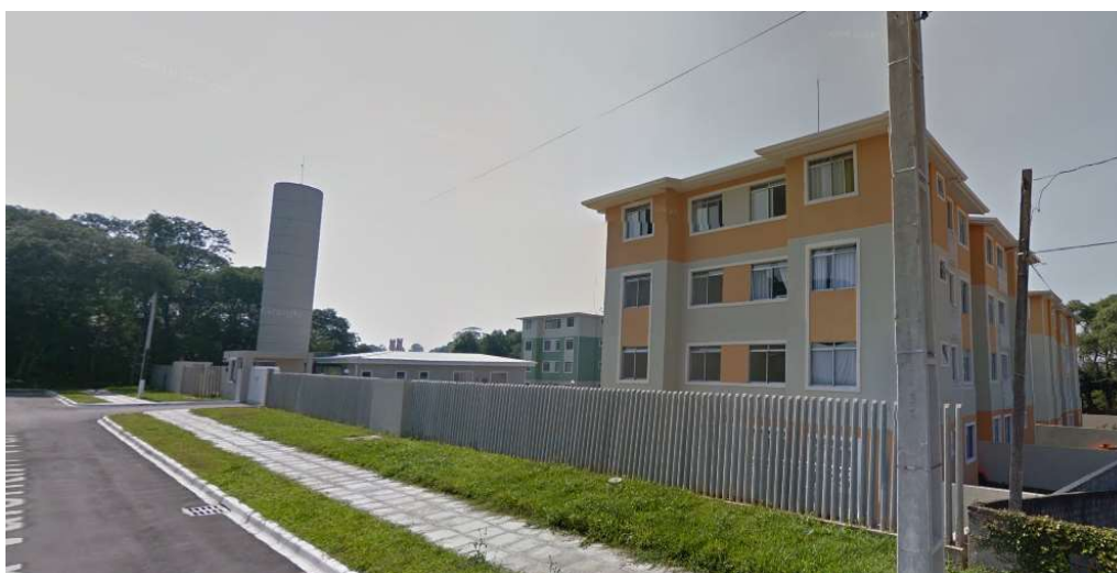
Figura 16. Conjunto Habitacional Vertical com 4 pavimentos, a 450 metros do empreendimento, localizado na Rua Valentim Wall
