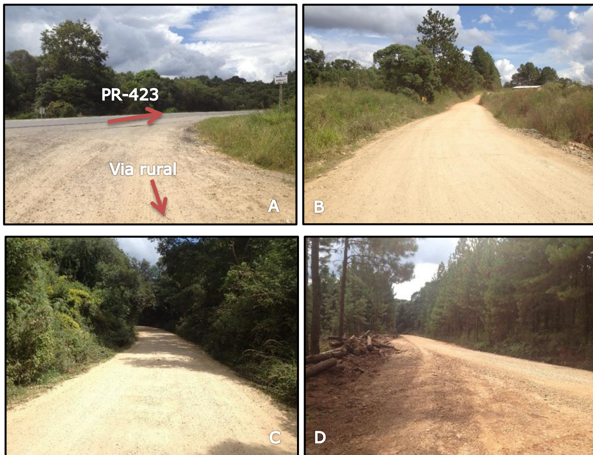
Figura 23 – Via rural secundária que dá acesso ao empreendimento.
