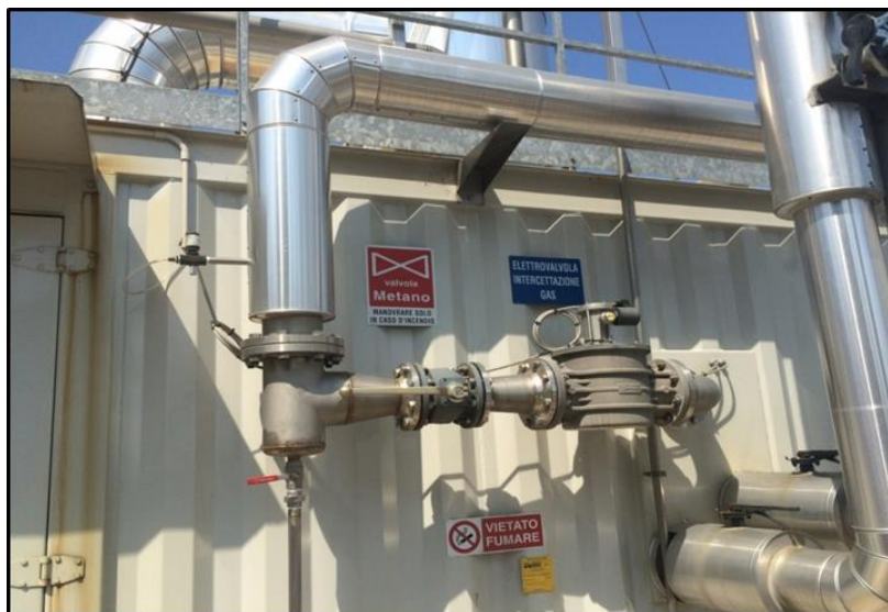
Figura 16 – Modelo de válvula externa que será instalada para interromper o fluxo de biogás.
