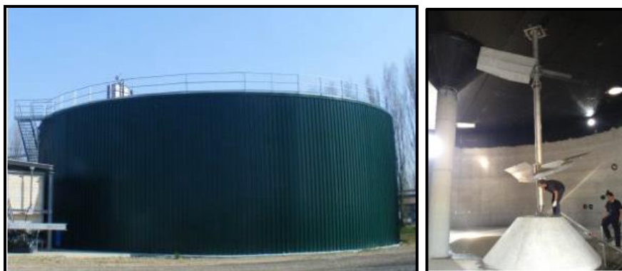
Figura 7 - Exemplo de biodigestor e seu respectivo misturador que será instalado no empreendimento.
