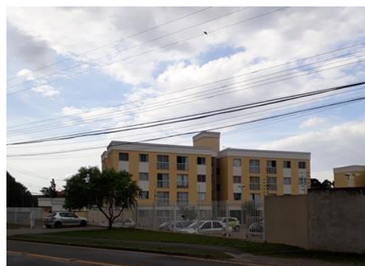
Figura 12- Conjunto Residencial - Rua Vital Brasil
