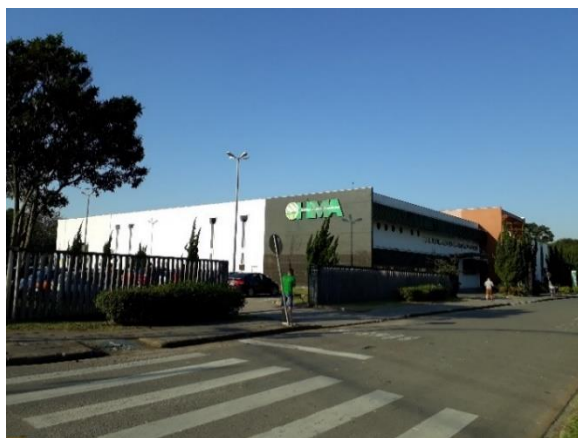
Figura 46- Hospital Municipal de Araucária
