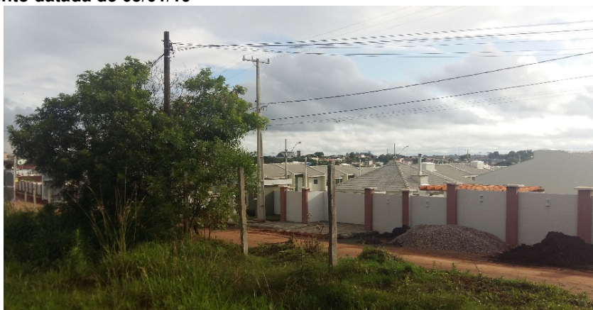
Figura 14: Rede de energia elétrica e falta de iluminação pública na Rua Pelicano em frente ao empreendimento datada de 05/01/19
