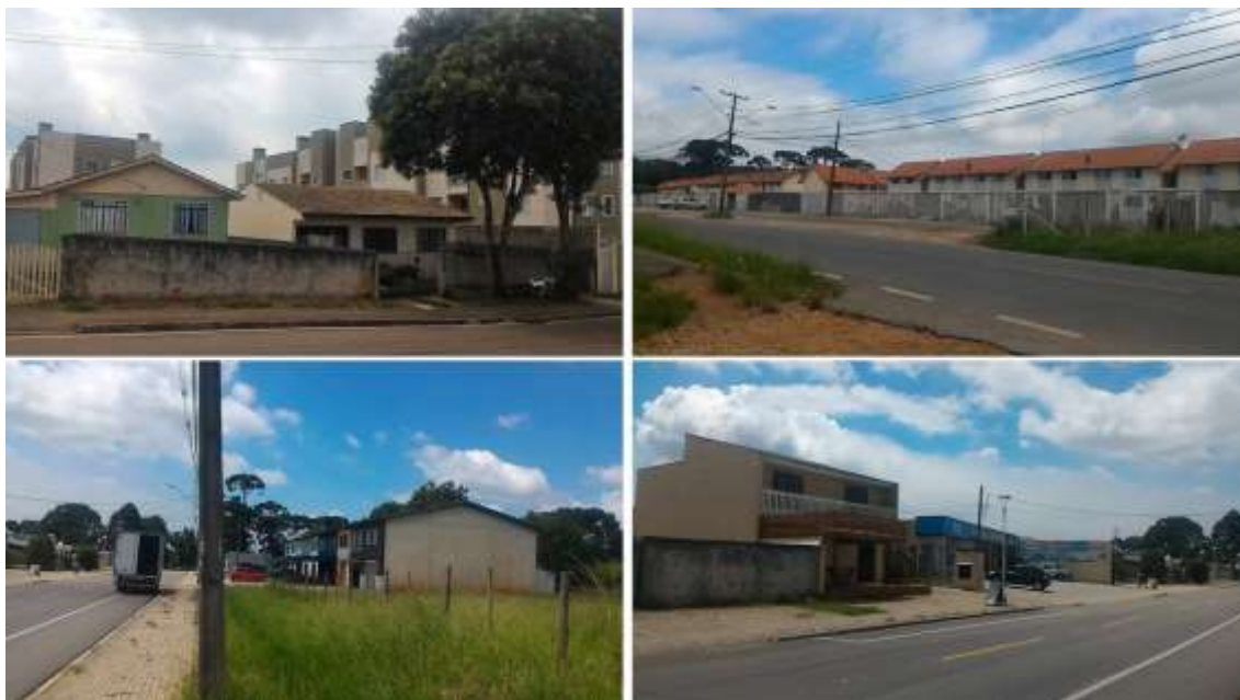
Figura 12: Detalhe das habitações e comércios na AID e All do empreendimento.
