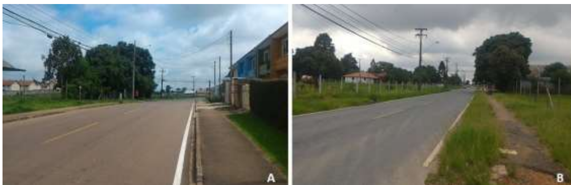
Figura 8: Situação atual (Janeiro de 2019) das vias de acesso do empreendimento. Onde: A – Detalhe da rua Professor João Chorosnick que será a rua de acesso para a fase de implantação e operação do empreendimento; B – Detalhe da Av. N. Sra. dos Remédios no local de acesso ao Centro de Lojas.
