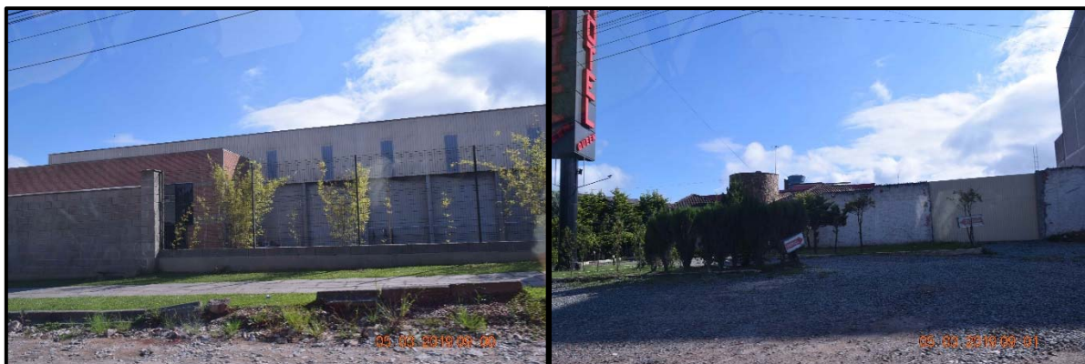
FIGURA 34 – REGISTRO FOTOGRÁFICO DA EMPRESA ALÇABRAS (À ESQUERDA) E DO MOTEL QUEEN (À DIREITA), AMBOS NA RUA CÉLIO JOSÉ FRANCESCHI.
