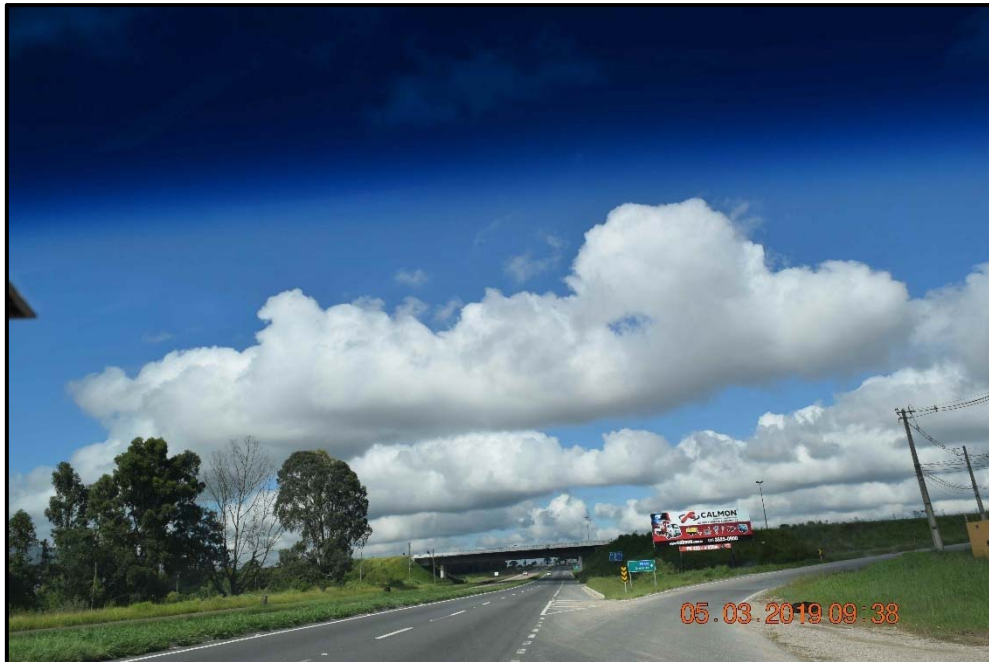
FIGURA 14 – RODOVIA BR-476 (RODOVIA DO XISTO – VIA EXPRESSA), EM DETALHE VIADUTO QUE PERMITE ACESSO À AV. DAS ARAUCÁRIAS.
