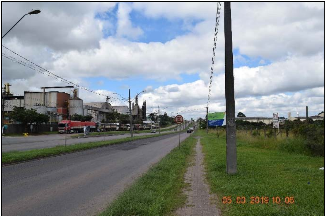
FIGURA 53 – PASSEIO EXISTENTE NA TESTADA DA AV. DAS ARAUCÁRIAS.
