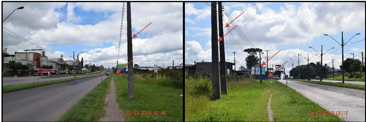
FIGURA 57 – POSTES SITUADOS NA TESTADA DA AV. DAS ARAUCÁRIA.
