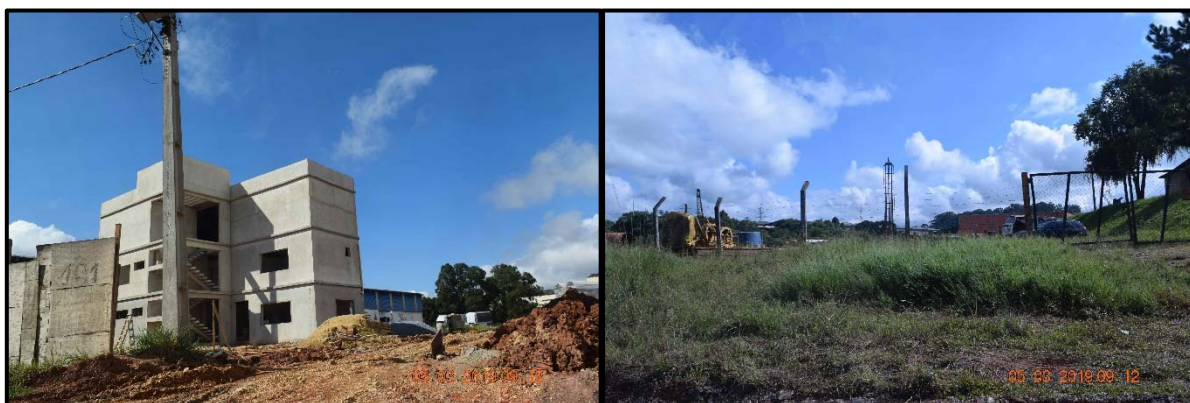
FIGURA 32 – REGISTRO FOTOGRÁFICO DE EDIFICAÇÃO EM CONSTRUÇÃO (À ESQUERDA) E DE TERRENO DA BENEPAR (À DIREITA), AMBOS NA RUA MARTINS DEDA.
