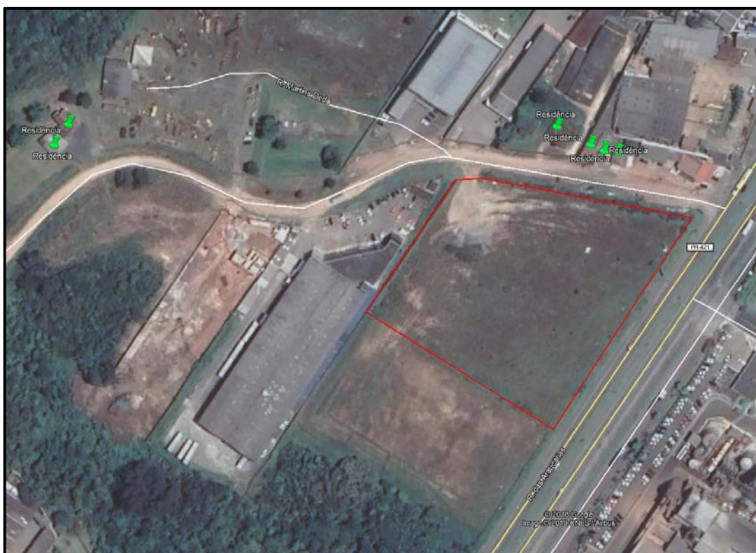
FIGURA 40 – USOS RESIDENCIAIS (TOLERÁVEIS) NO ENTORNO (AID) DO EMPREENDIMENTO. ELABORAÇÃO: COGEP – COMPANHIA DE GEOTECNOLOGIAS DO PARANÁ LTDA. (2019).
