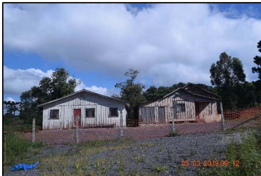
FIGURA 43 – USOS RESIDENCIAIS (TOLERÁVEIS) NO ENTORNO (AID) DO EMPREENDIMENTO, NA RUA MARTINS DEDA.
