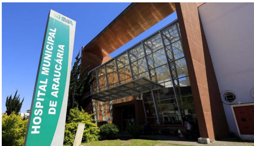
Figura 34- Hospital Municipal de Araucária
