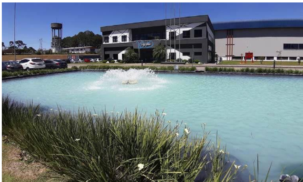
Figura 11 – Lagoa de polimento de efluentes na entrada do empreendimento
