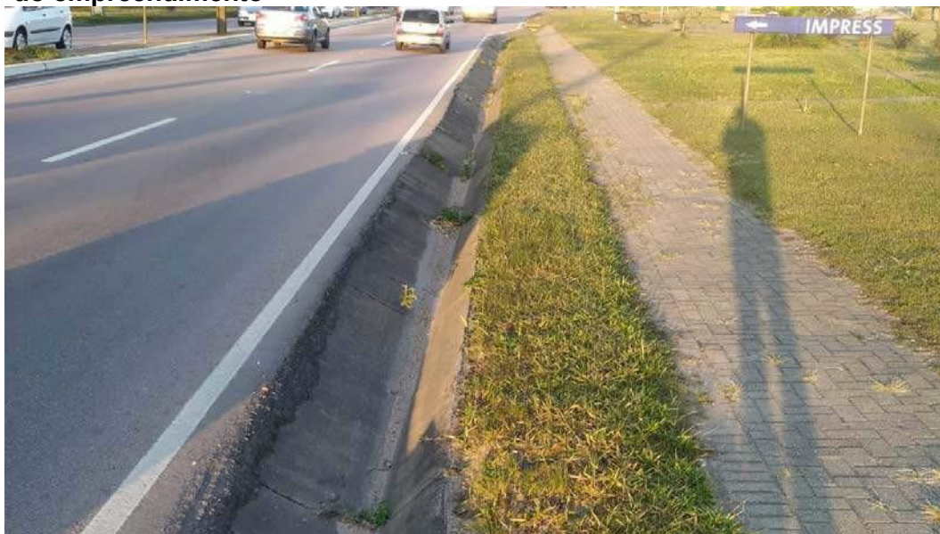
Figura 22 - Canaleta de drenagem de águas pluviais existente no entorno do empreendimento
