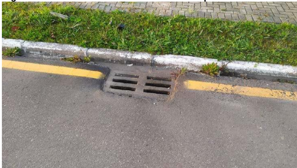
Figura 24 - Bueiro existente no entorno do empreendimento
