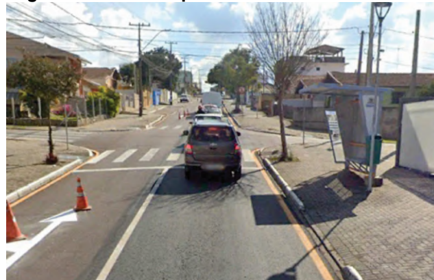
Figura 32: Abrigo de Ônibus situado na Rua Miguel Bertolino esquina com Rua Tereza Bini
