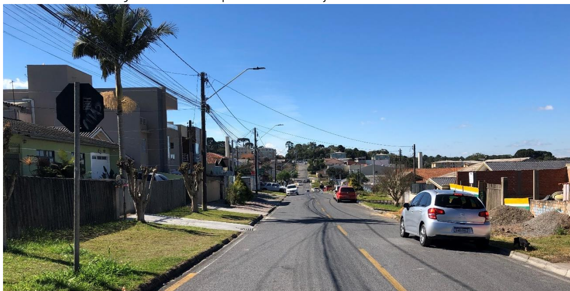
Figura 15. AID do empreendimento: majoritariamente residencial
