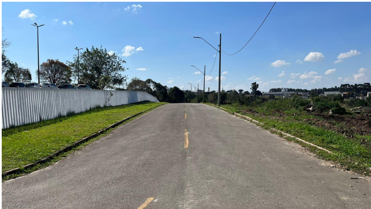
FIGURA 10. RUA ROZÁLIA WZOREK (VIA DE FRENTE AO IMÓVEL) – RUA SEM SAÍDA
