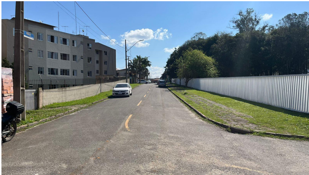
FIGURA 12. RUA ROZÁLIA WZOREK (VIA LATERAL AO IMÓVEL)
