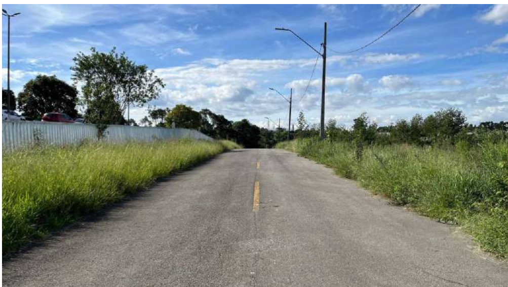
FIGURA 5 - FOTOS DA RUA ROZÁLIA WZOREK - TRECHO 02
