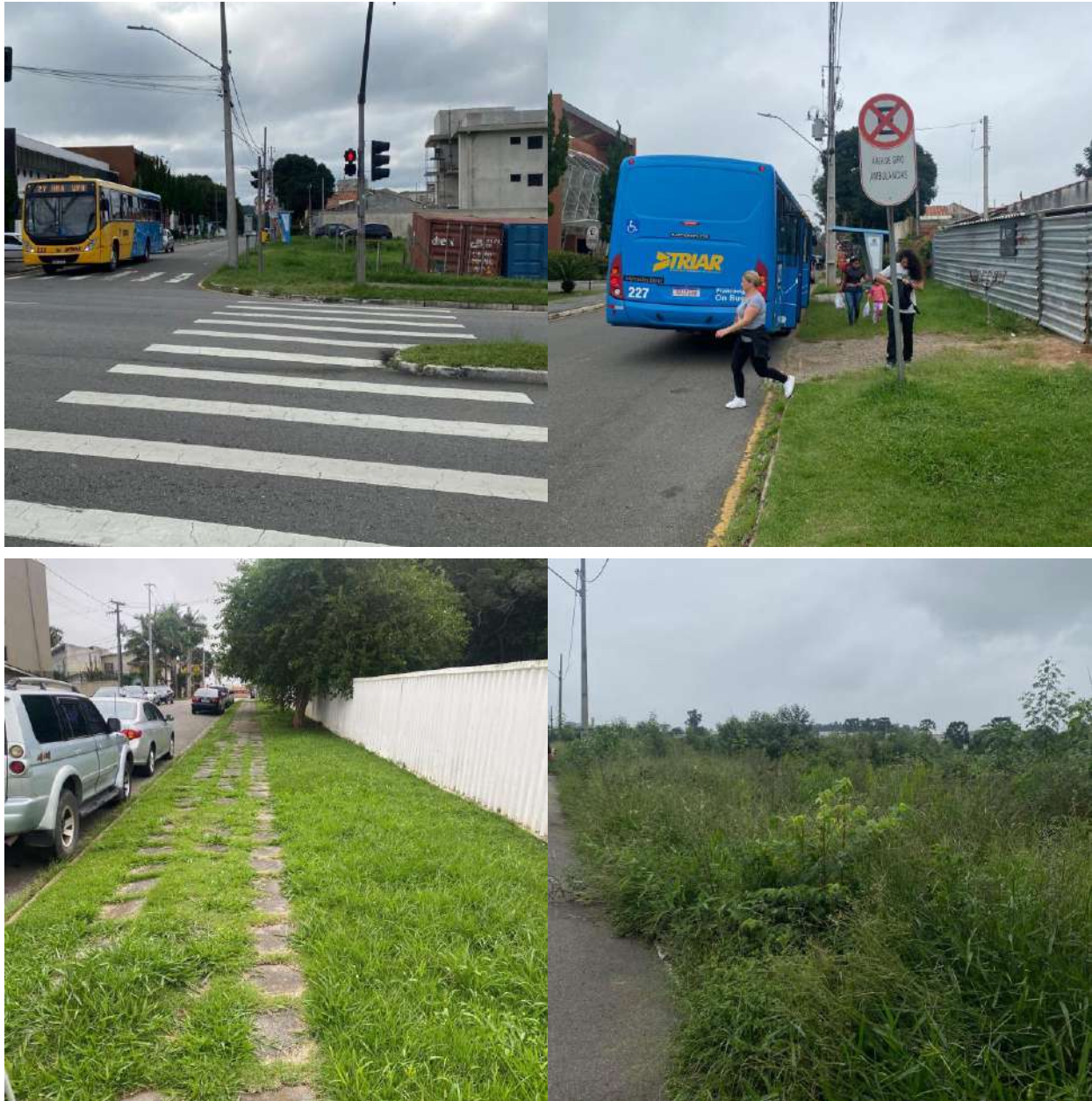
FIGURA 30 - FOTOS DE ÁREAS DO ENTORNO COM ACESSIBILIDADE INADEQUADA
