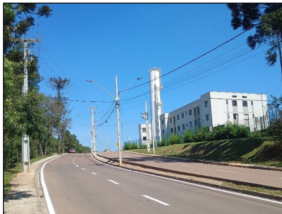
Fotografia 70. Poste de Luz localizado na Rua César Hasselmann. Fonte: Acervo ANDES (2024).
