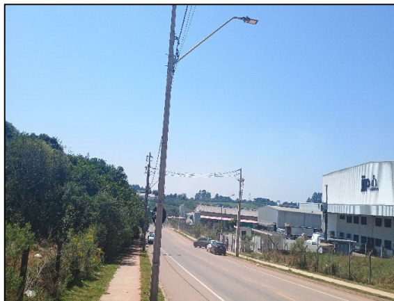
Fotografia 50 Postes de Energia localizado na Rua Ubirajara Sávio Torres. Fonte: Acervo ANDES (2024).
