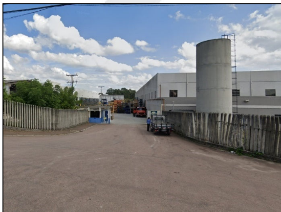
Fotografia 38. Nelson Global Products. Localizada na Av. dos Pinheirais, 675 - Capela Velha, Araucária - PR, Fonte: Acervo ANDES (2024).
