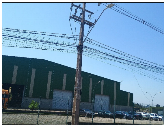
Fotografia 62. Poste de Luz localizado na Rua Pedro de Alcântara Meira. Fonte: Acervo ANDES (2024).
