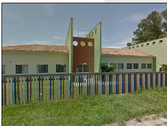
Fotografia 101. CRAS Fazenda Velha, Araucária -PR. Fonte: Google Street View adaptado por ANDES (2024).
