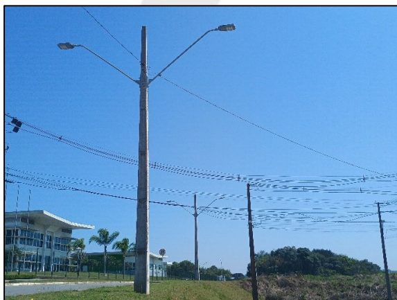
Fotografia 61. Poste de Luz localizado na Rua Pedro de Alcântara Meira. Fonte: Acervo ANDES (2024).
