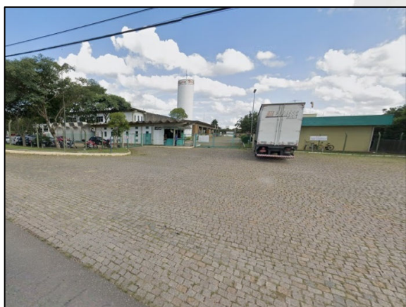
Fotografia 116 Tri-Sure Araucária. Localizada na Av. dos Pinheirais, 465 - Estação, Araucária - PR, Fonte: Acervo ANDES (2024).
