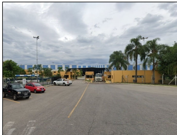
Fotografia 35. Gonvarri Paraná S/A. Localizada na Av. das Nações, 1000 - Capela Velha, Araucária - PR, Fonte: Acervo ANDES (2024).
