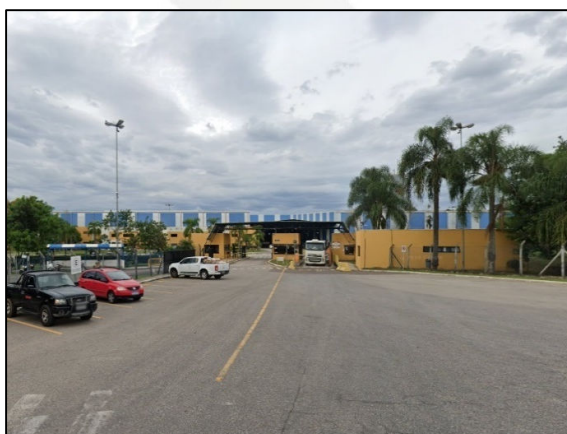
Fotografia 119 Gonvarri Paraná S/A. Localizada na Av. das Nações, 1000 - Capela Velha, Araucária - PR, Fonte: Acervo ANDES (2024).
