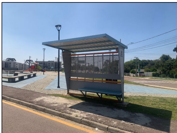
Fotografia 106. Ponto de ônibus, Boqueirão/Monalisa/Tropical sentido terminal Bairro. Localizado na Rua Ludovina Furman Boqueirão, Araucária - PR. Fonte: Acevo ANDES, 2024
