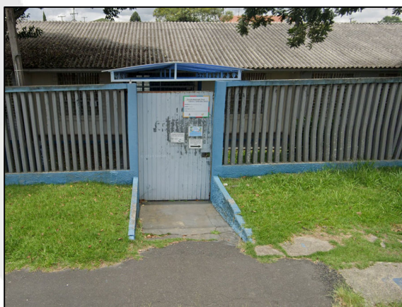
Fotografia 80. Escola Municipal Prefeito Alderico Zanardini Ozório, localizada na Rua Carlos de Lima, 160 - Estação, Araucária - PR.
