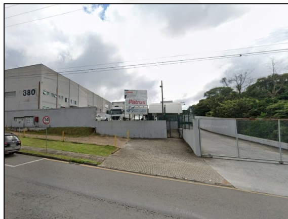
Fotografia 39. Patrus Transportes. Localizada na Av. das Cerejeiras, 380 - Capela Velha, Araucária - PR, Fonte: Acervo ANDES (2024).
