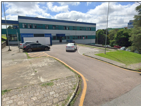
Fotografia 91. UBS Centro localizada na Rua Dr. Guilherme da Mota Corrêa. Fonte: Google Street View adaptado por ANDES (2024).
