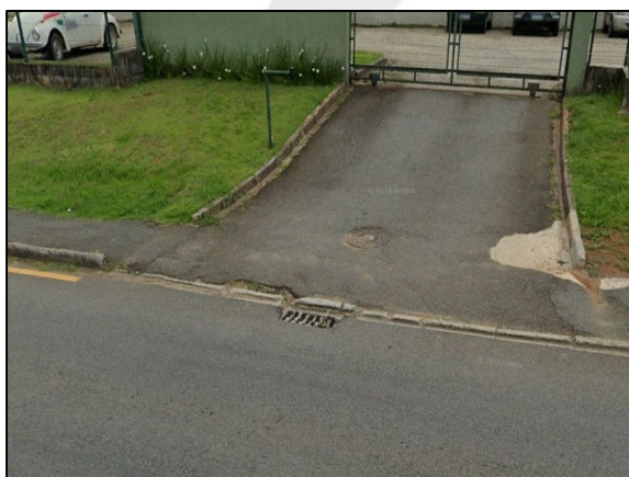
Fotografia 59. Galeria Pluvial localizado na Rua Sebastião Lemos. Fonte: Acervo ANDES (2024).
