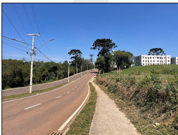
Fotografia 47. Postes de Energia localizado na Rua César Hasselmann. Fonte: Acervo ANDES (2024).
