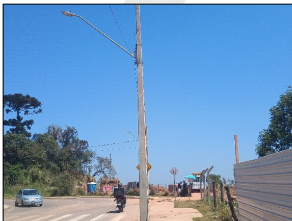
Fotografia 67. Poste de Luz em frente ao empreendimento, localizado na Rua Ubirajara Sávio Torres. Fonte: Acervo ANDES (2024).
