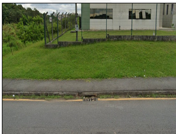
Fotografia 60 Galeria Pluvial localizado na Rua Sebastião Lemos. Fonte: Acervo ANDES (2024).
