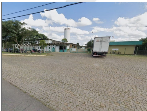
Fotografia 32. Tri-Sure Araucária. Localizada na Av. dos Pinheirais, 465 - Estação, Araucária - PR, Fonte: Acervo ANDES (2024).
