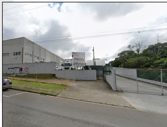
Fotografia 123 Patrus Transportes. Localizada na Av. das Cerejeiras, 380 - Capela Velha, Araucária - PR, Fonte: Acervo ANDES (2024).
