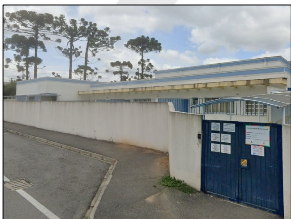
Fotografia 81. CMEI Norma Von Berneck, localizada na Rua José Maria dos Anjos, 50 - Capela Velha, Araucária - PR.
