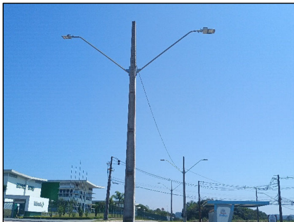
Fotografia 63. Poste de Luz localizado na Rua Pedro de Alcântara Meira. Fonte: Acervo ANDES (2024).
