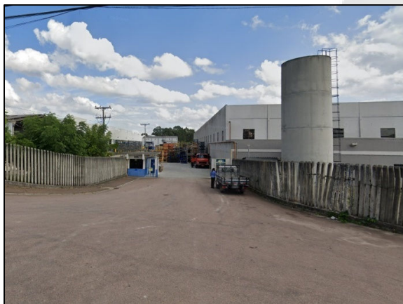
Fotografia 122 Nelson Global Products. Localizada na Av. dos Pinheirais, 675 - Capela Velha, Araucária - PR, Fonte: Acervo ANDES (2024).
