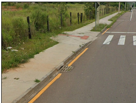
Fotografia 53. Galeria Pluvial localizada na Rua Ubirajara Sávio Torres. Fonte: Acervo ANDES (2024).
