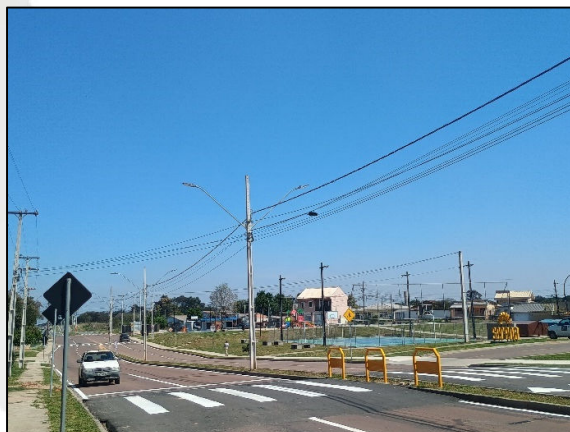
Fotografia 72. Poste de Luz localizado na Rua César Hasselmann. Fonte: Acervo ANDES (2024).
