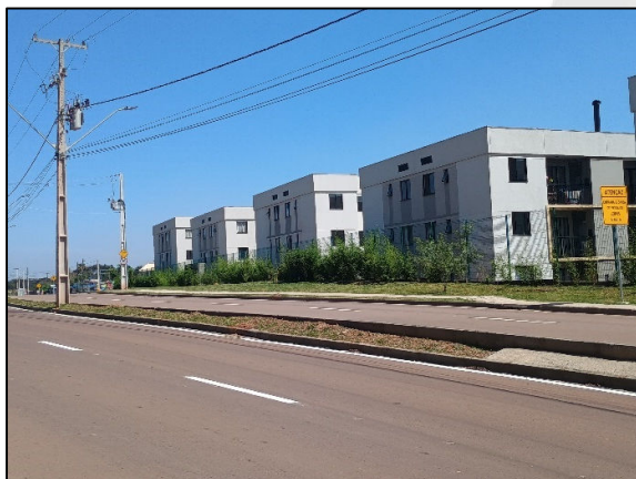
Fotografia 71. Poste de Luz localizado na Rua César Hasselmann. Fonte: Acervo ANDES (2024).
