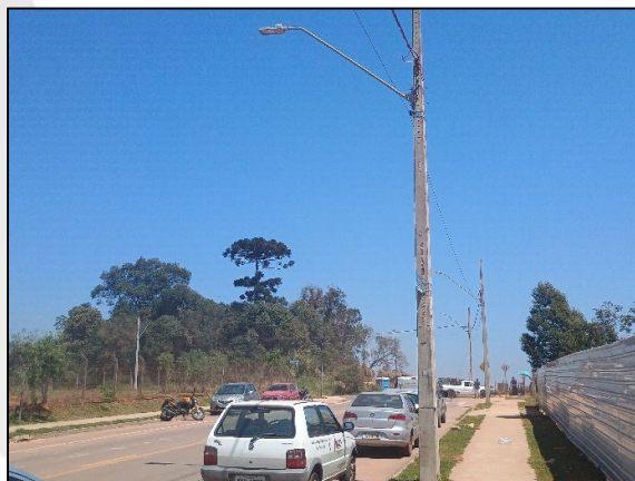
Fotografia 66. Poste de Luz em frente ao empreendimento, localizado na Rua Ubirajara Sávio Torres. Fonte: Acervo ANDES (2024).
