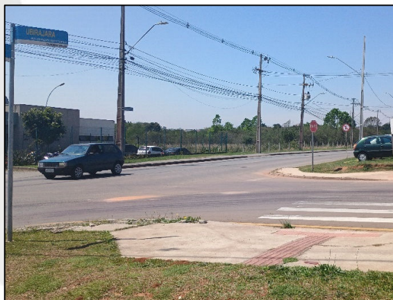
Fotografia 52 Postes de Energia localizado na Rua Pedro de Alcântara Meira. Fonte: Acervo ANDES (2024).
