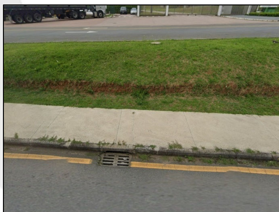
Fotografia 58. Galeria Pluvial localizado na Rua Pedro de Alcântara Meira. Fonte: Acervo ANDES (2024).
