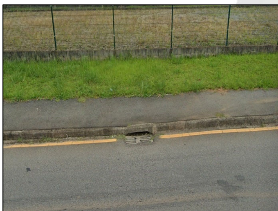
Fotografia 57. Galeria Pluvial localizado na Rua Pedro de Alcântara Meira. Fonte: Acervo ANDES (2024).
