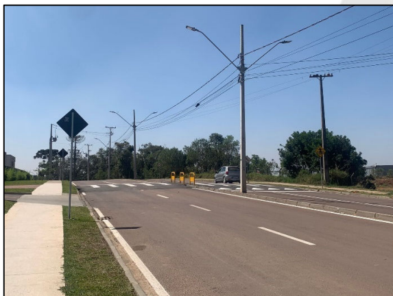
Fotografia 51 Postes de Energia localizado na Rua Cézar Hasselmann. Fonte: Acervo ANDES (2024).
