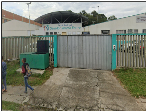
Fotografia 78. Escola Municipal Senador Marcos Freire localizada na Rua Francisco Gondek, 250 - Jardim Maia, Araucária - PR.
