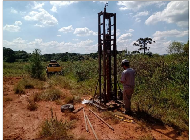
Fotografia 03: Execução da sondagem mecanizada ST-06 (Andes Geologia, 2023).
