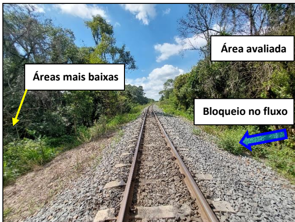
Fotografia 19: Aterro de ferrovia que constitui uma grande barreira ao escoamento superficial (Andes Geologia, 2024).
