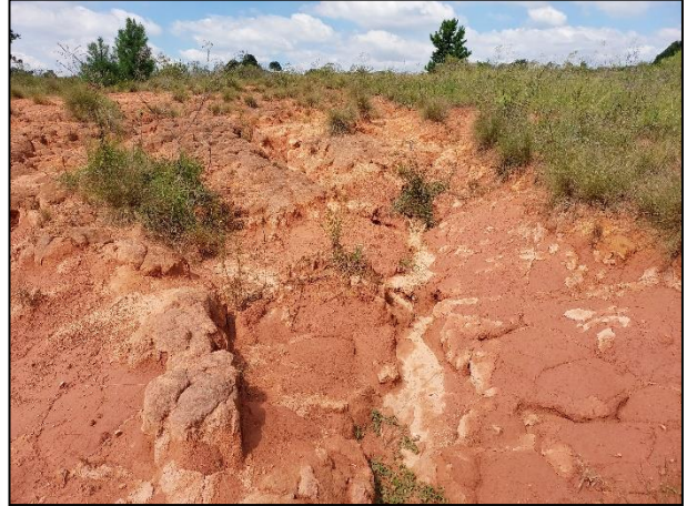
Fotografia 32: Erosão no terreno (Andes Geologia, 2024).
