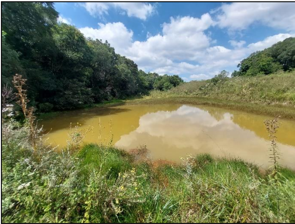
Fotografia 36: Barramento artificial existente no lote avaliado (Andes Geologia, 2024 ).
