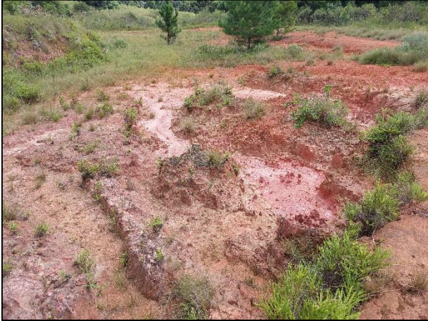
Fotografia 31: Erosão no terreno (Andes Geologia, 2024).
