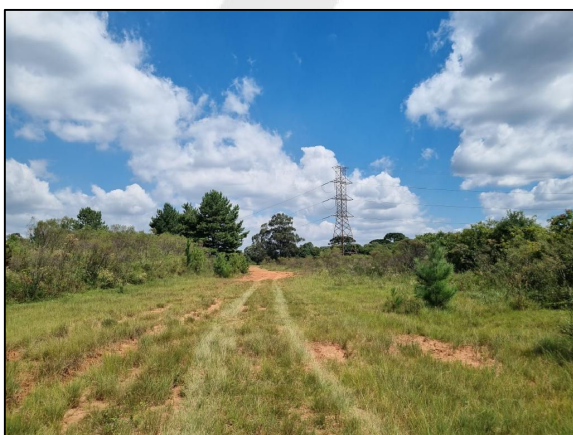
Fotografia 7. Estrada localizada na porção sul do terreno no Ponto 5. Fonte: Acervo ANDES (2024).
