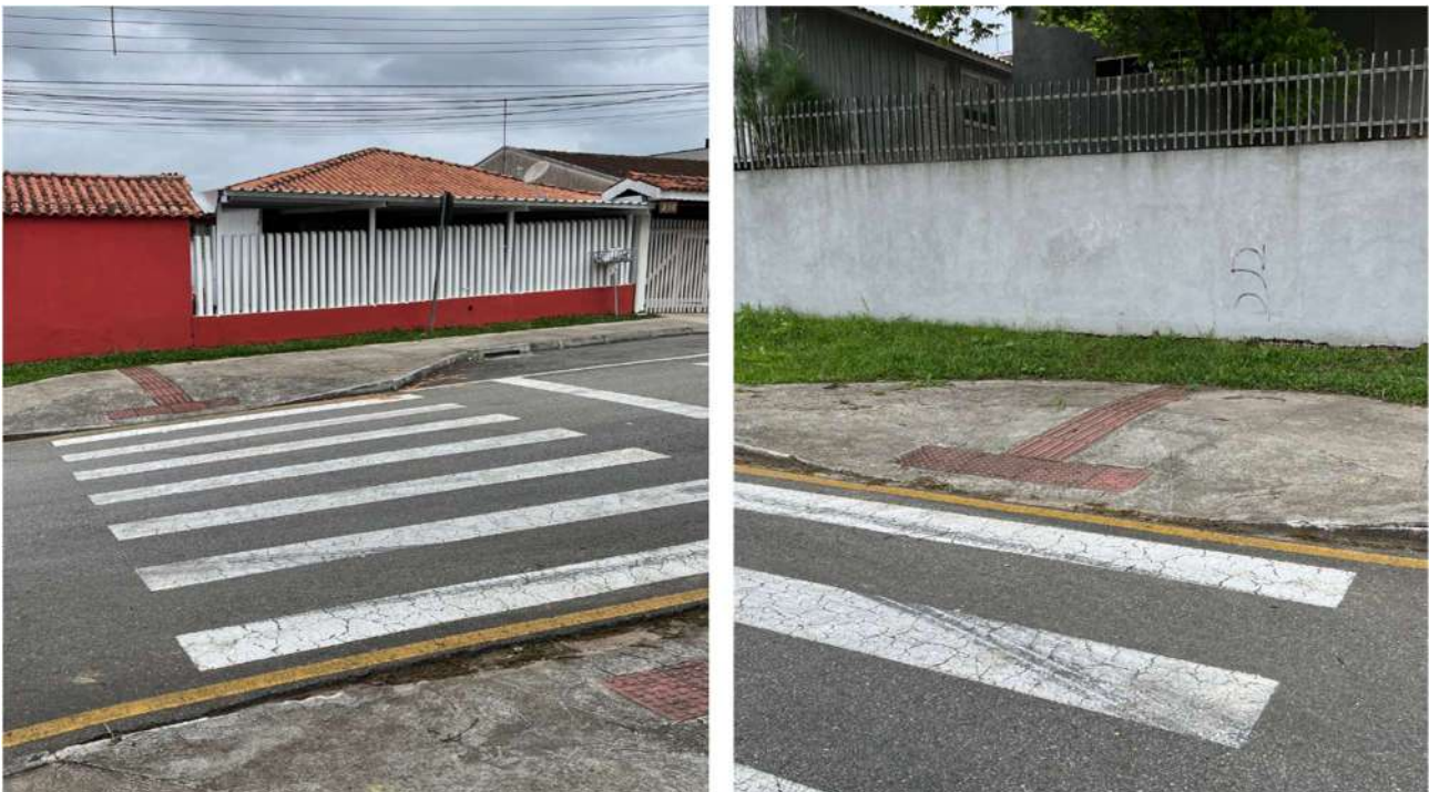
FIGURA 31 - FOTOS DE ÁREAS DO ENTORNO COM ACESSIBILIDADE INADEQUADA
