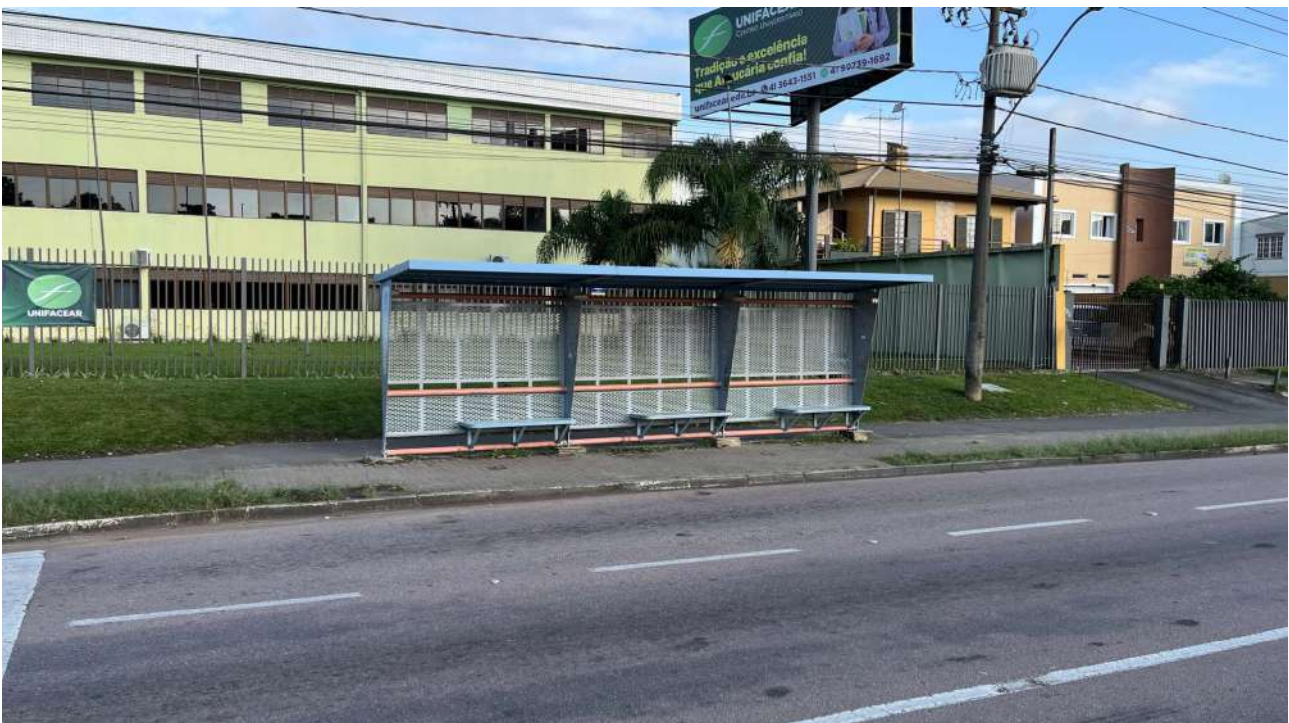
FIGURA 27 - FOTOS DO PONTO 02 - AV. DAS ARAUCÁRIAS - SENTIDO TERMINAL VILA ANGÉLICA
