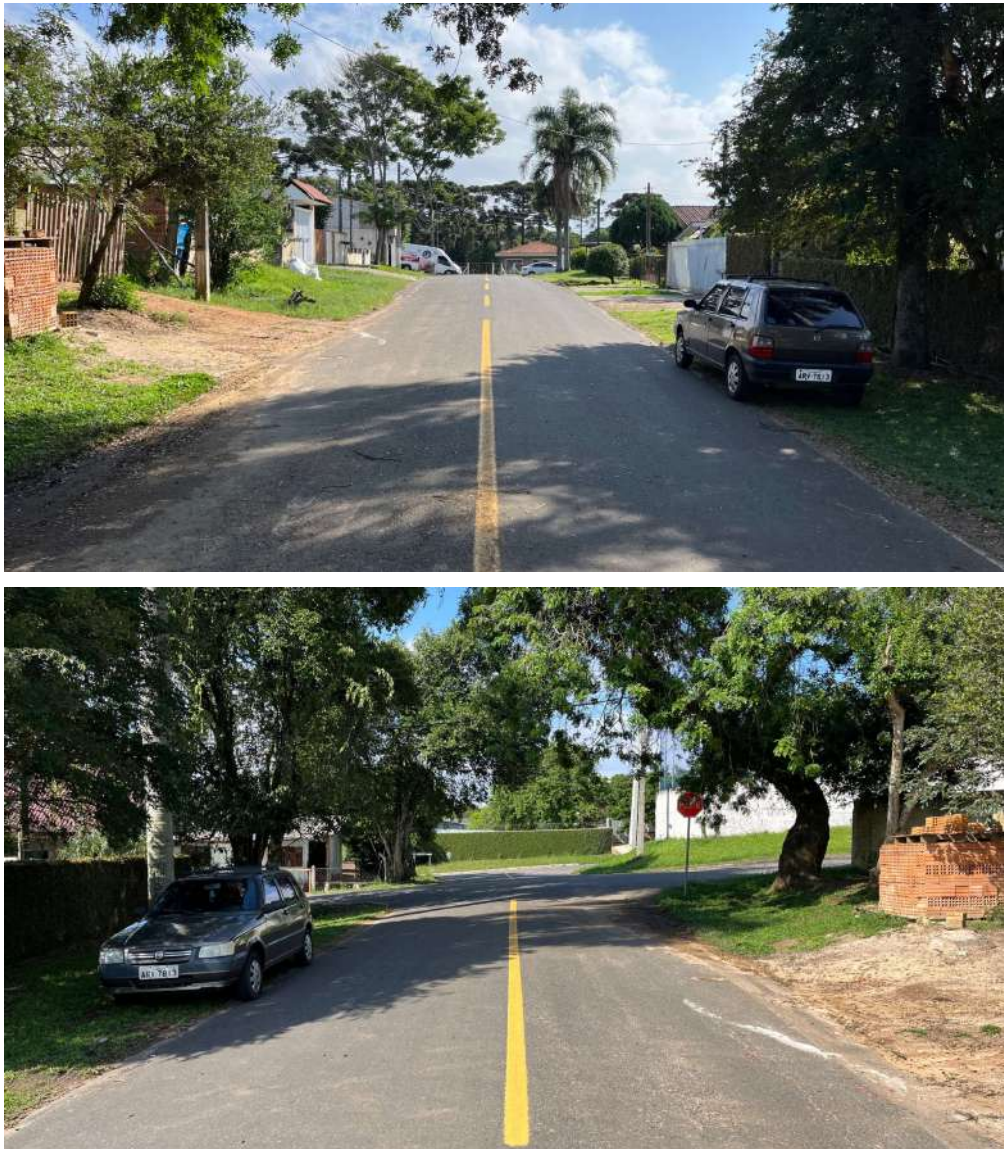
FIGURA 20 - FOTOS DA RUA JOSÉ MARQUÊS
