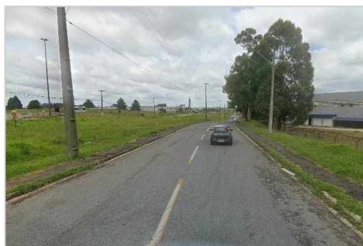
Figura 80. Acesso à Rua Curió. Fonte: Street View, 2025.
