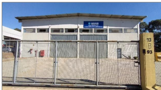
Figura 29. Welflex Pintura Eletrostática - R. Célio José Franceschi, 93 - Chapada. Fonte: Street View, 2025.
