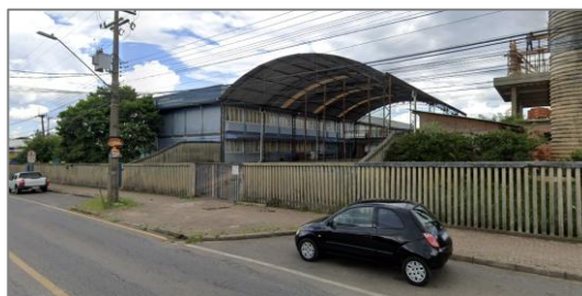
Figura 49. Equipamento de Educação id 4. Fonte: Google Street View, 2025.
