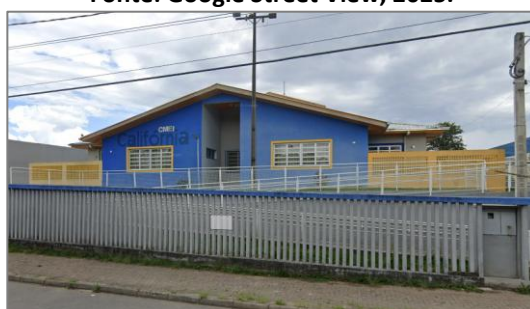
Figura 57. Equipamento de Educação id 12. Fonte: Google Street View, 2025.
