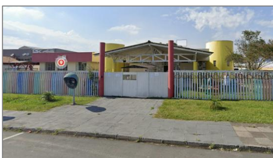
Figura 56. Equipamento de Educação id 11. Fonte: Google Street View, 2025.
