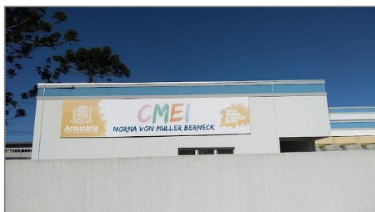
Figura 52. Equipamento de Educação id 7. Fonte: Google Street View, 2025.
