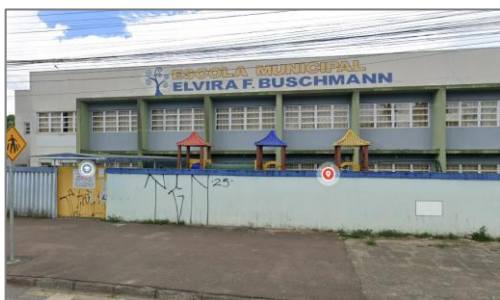
Figura 54. Equipamento de Educação id 9. Fonte: Google Street View, 2025.
