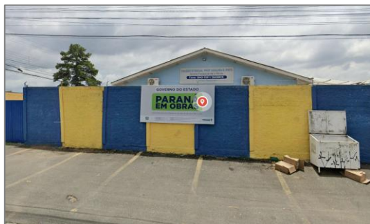
Figura 46. Equipamento de Educação id 1. Fonte: Google Street View, 2025.
