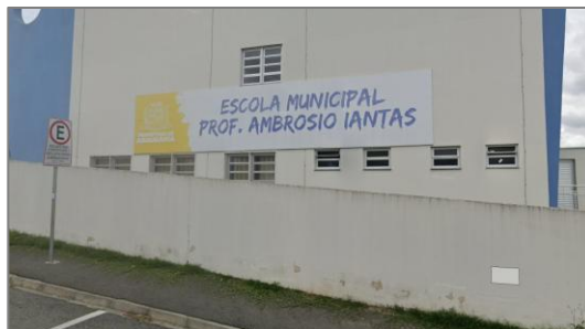
Figura 51. Equipamento de Educação id 6. Fonte: Google Street View, 2025.
