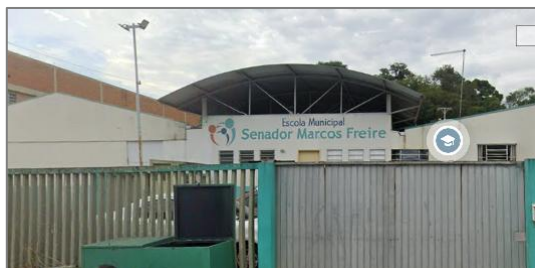
Figura 50. Equipamento de Educação id 5. Fonte: Google Street View, 2025.
