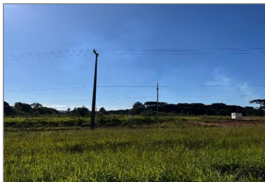
Figura 42. Postes de energia elétrica no entorno no terreno.
