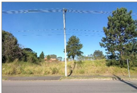
Figura 41. Postes de energia elétrica no entorno no terreno (Av. das Nações).
