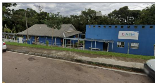
Figura 53. Equipamento de Educação id 8. Fonte: Google Street View, 2025.
