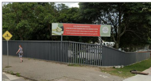
Figura 47. Equipamento de Educação id 2. Fonte: Google Street View, 2025.
