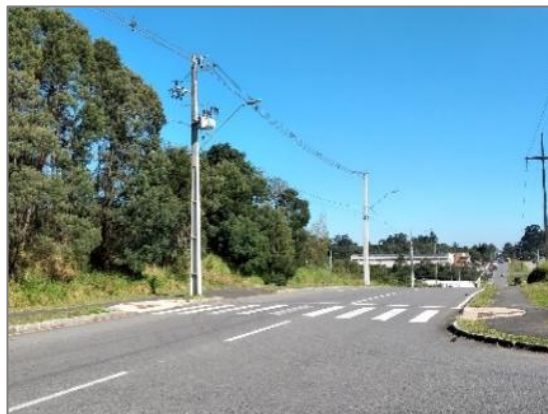
Figura 44. Postes de Iluminação entorno do terreno (Av. das Nações).
