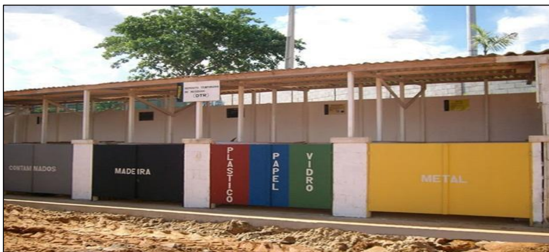
Figura 23. Baias de armazenamento de resíduos.
