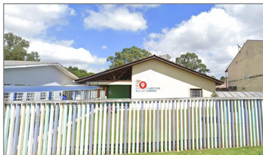
Figura 55. Equipamento de Educação id 10. Fonte: Google Street View, 2025.
