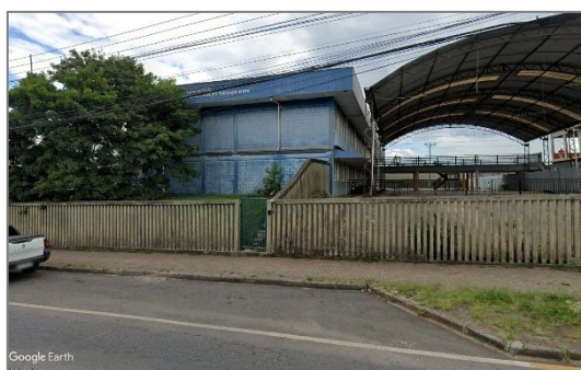
Figura 58. Equipamento de Educação id 13. Fonte: Google Street View, 2025.
