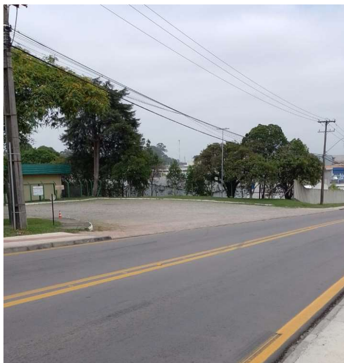
Figura 8 – Trecho da Avenida dos Pinheirais
