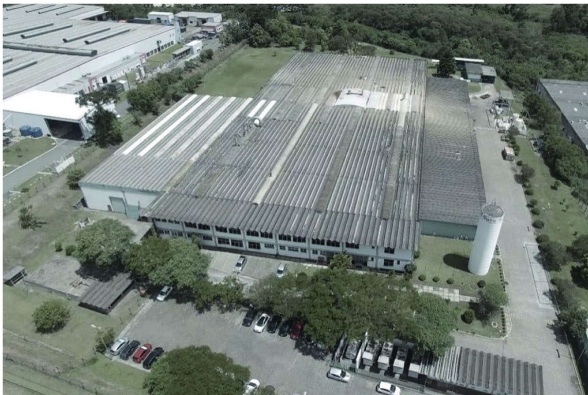
Figura 3 - Foto aérea da construção a partir da Av. dos Pinheirais. (Fonte: Greif.com, 2024)
