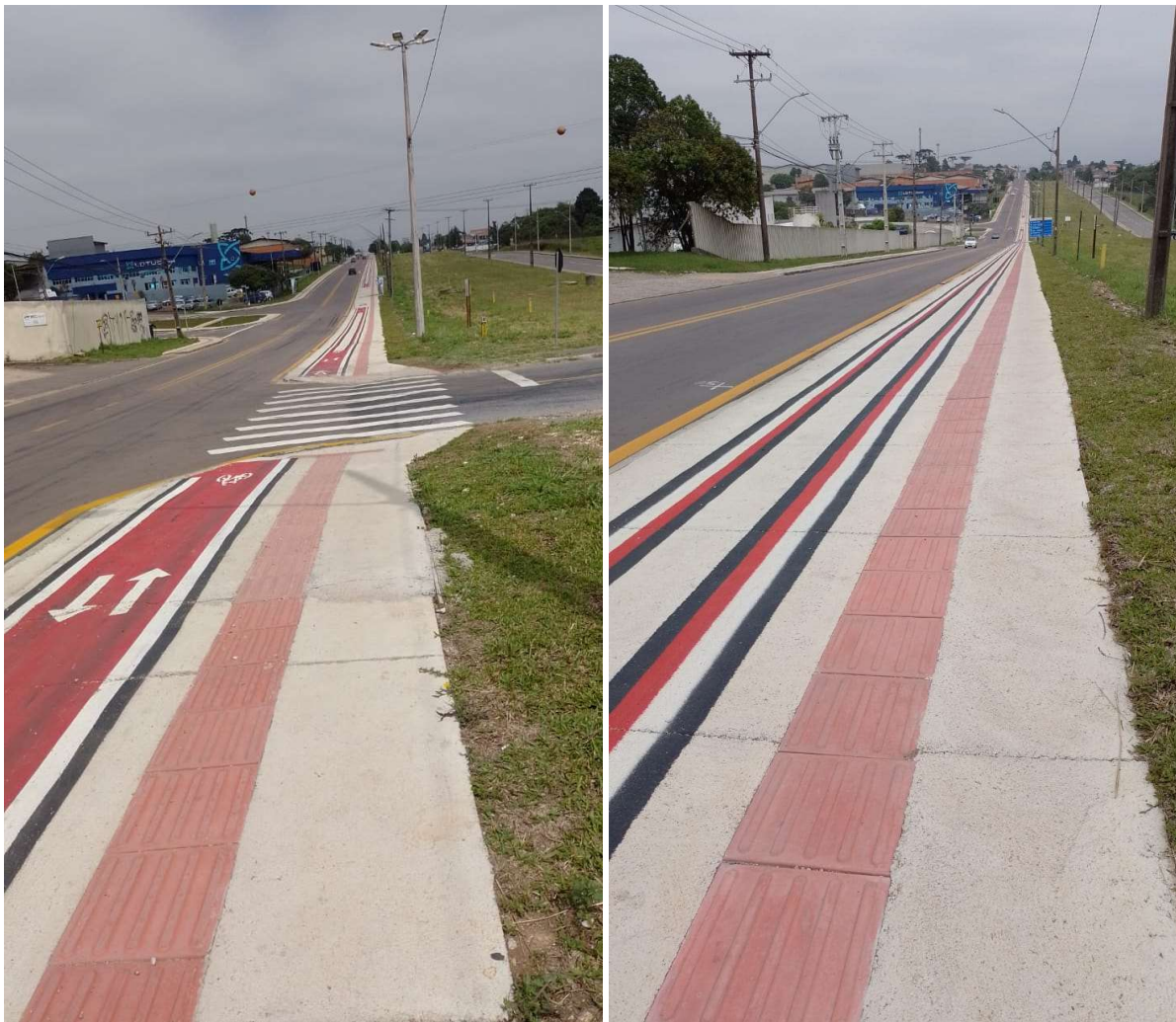
Figura 22 – Ciclofaixa na Av. dos Pinheiros
