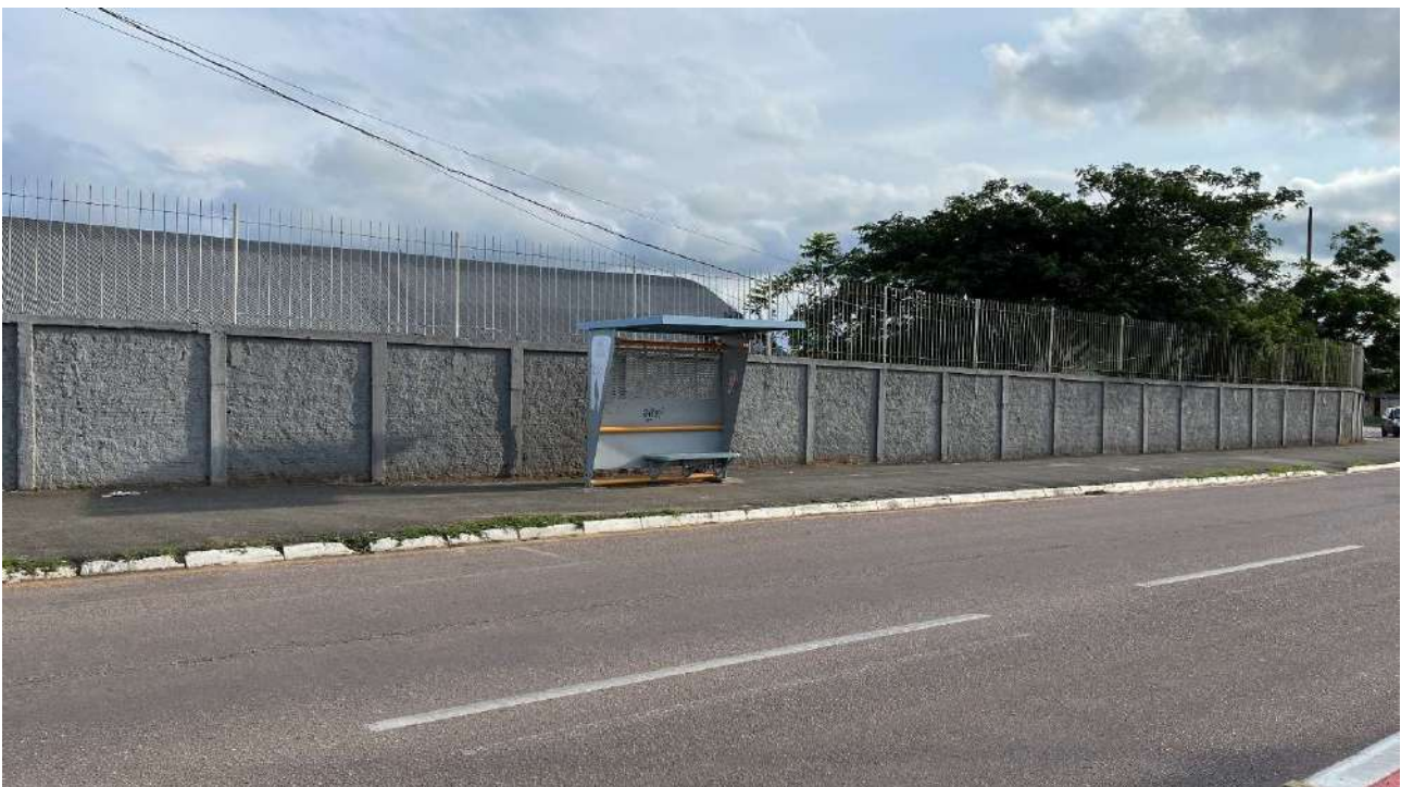
FIGURA 33 - FOTOS DO PONTO 02 - RUA NOSSA SENHORA DOS REMÉDIOS- SENTIDO TERMINAL VILA ANGÉLICA
