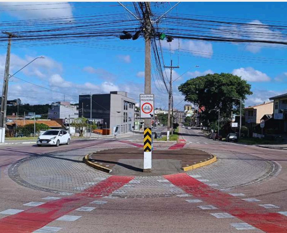
CICLOFAIXA EM ROTATÓRIA NA RUA MANOEL RIBAS
