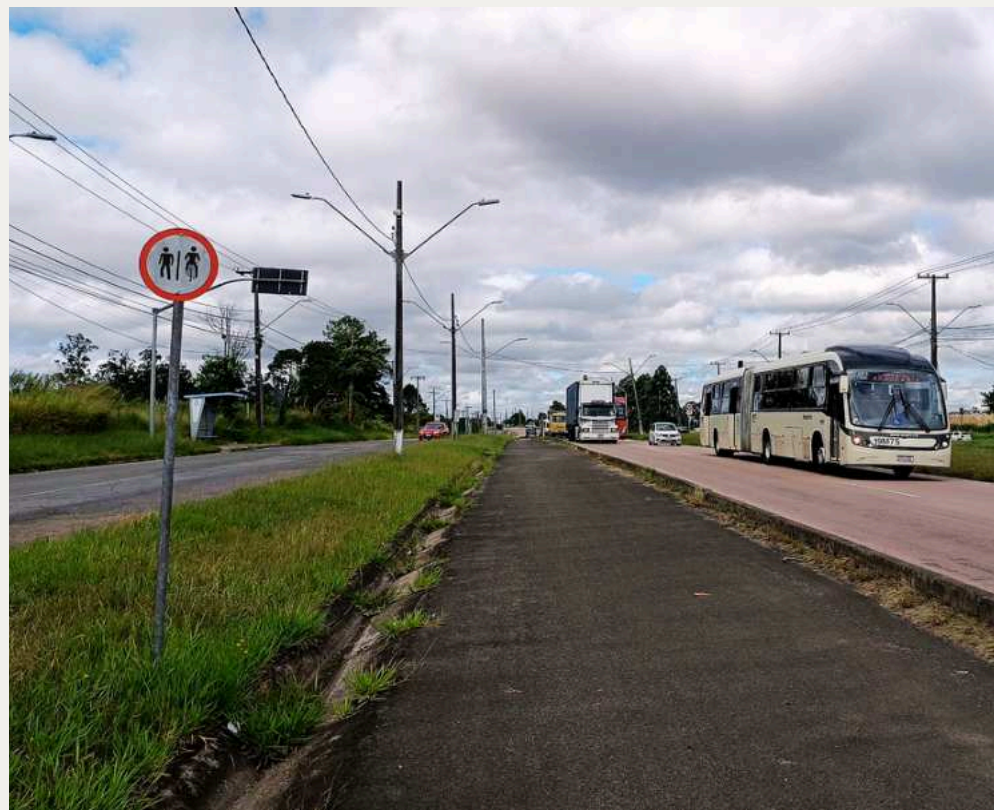
CICLOVIA AVENIDA DAS ARAUCÁRIAS
