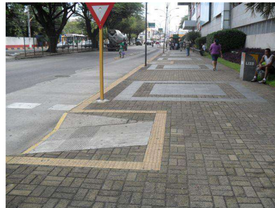
Figura 16: Exemplo de via bem dimensionada, com passeio em nível, rota acessível e acesso em rampa.
