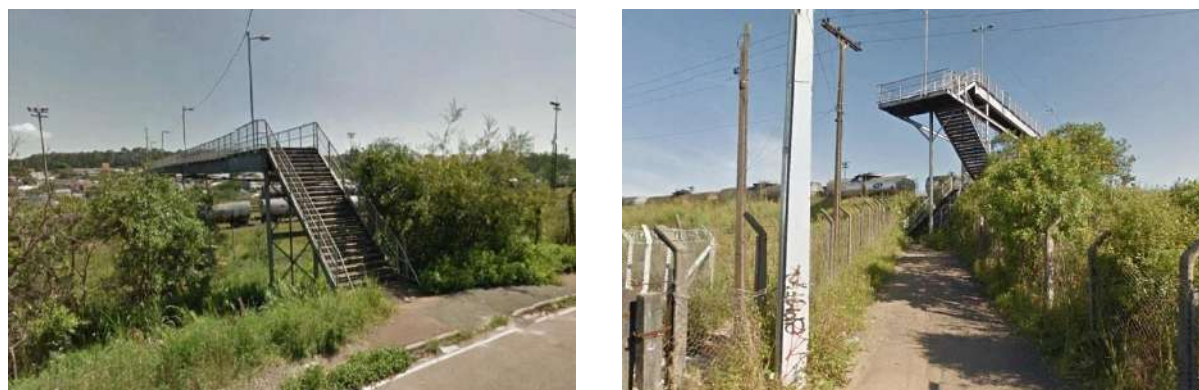
Figura 85: Situação da passarela - Vista da Rua Eduardo Sobânia e da Rua Dom Manoel da S. Delboux.
