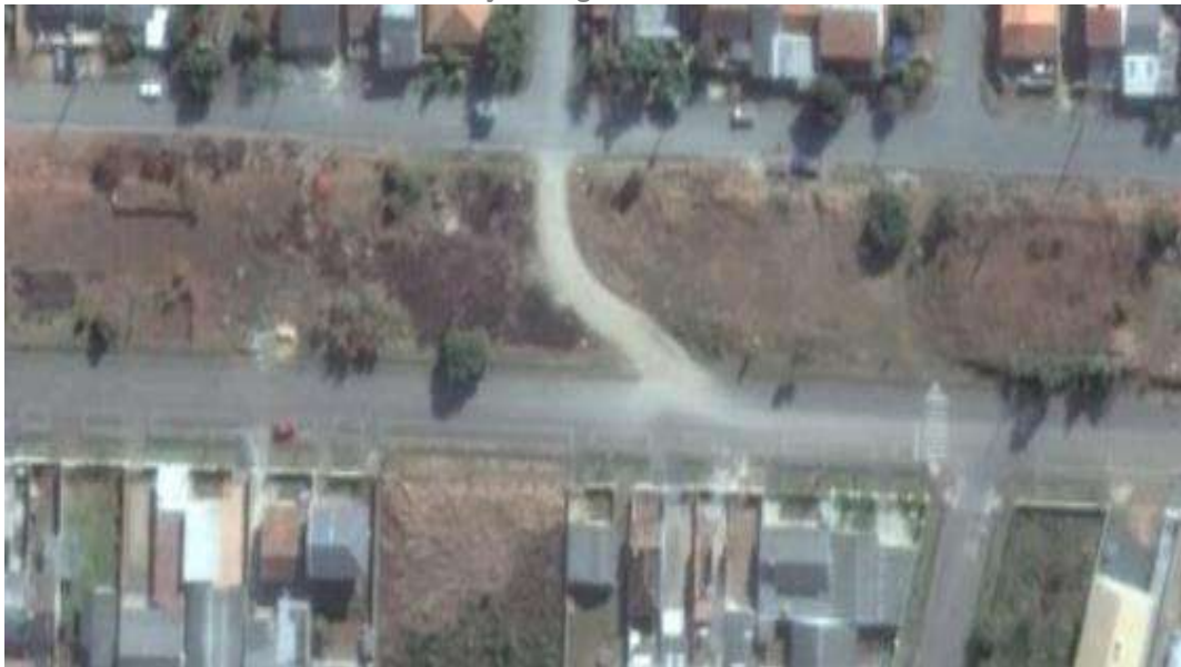
Figura 92: Travessia em nível da dutovia em situação irregular.
