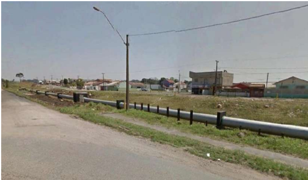
Figura 91: Afloramento do aqueduto na Avenida dos Pinheirais.
