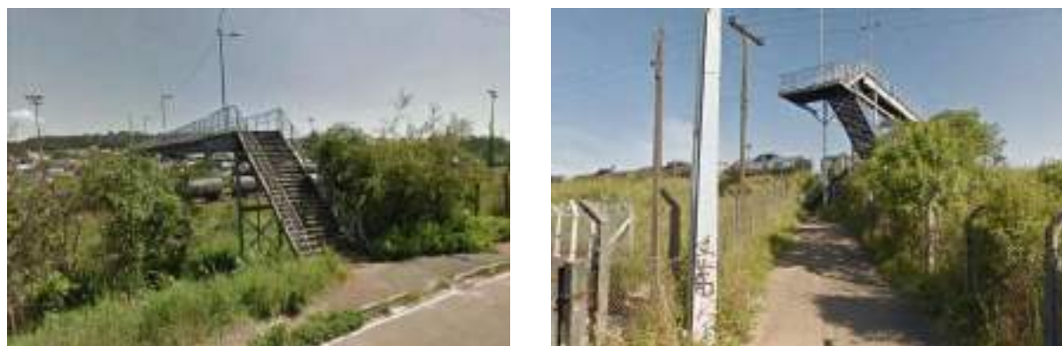
Figura 86: Situação da passarela - Vista da Rua Eduardo Sobânia e da Rua Dom Manoel da S. Delboux.
