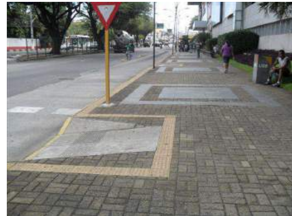
Figura 17: Exemplo de via bem dimensionada, com passeio em nível, rota acessível e acesso em rampa.
