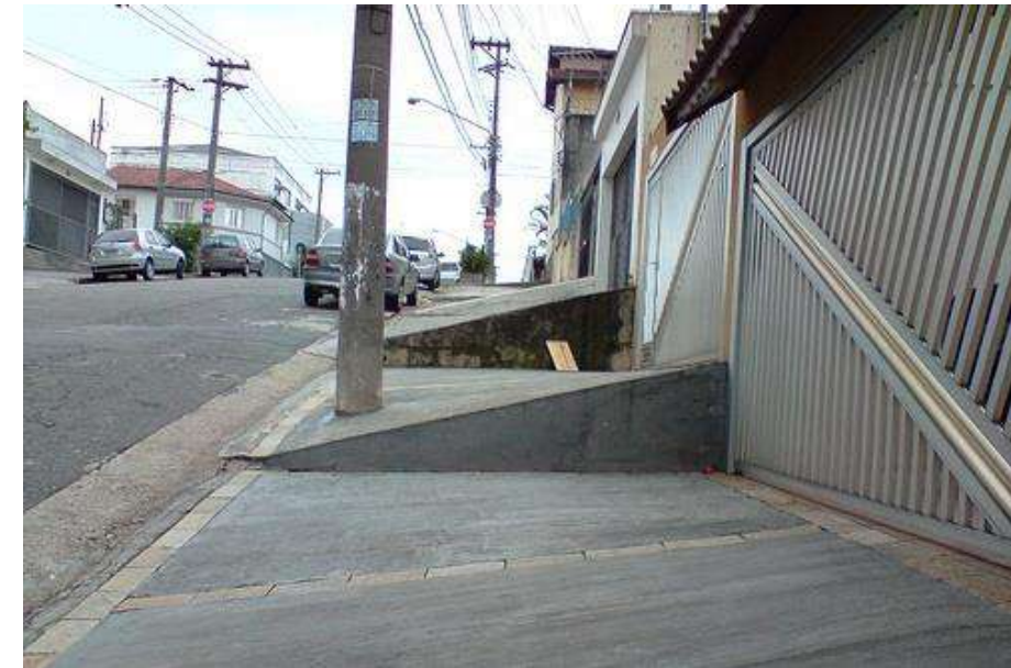
Figura 16: Exemplo de via mal dimensionada, de greide com inclinação elevada, calçada mal dimensionada, ocasionando a existência de degraus.
