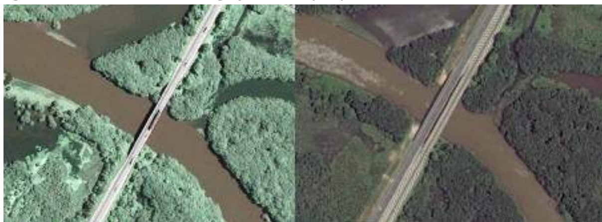
Figura 5: Ponte da BR-476 sobre o Rio Iguaçu em 2010 e já duplicada em 2014.
