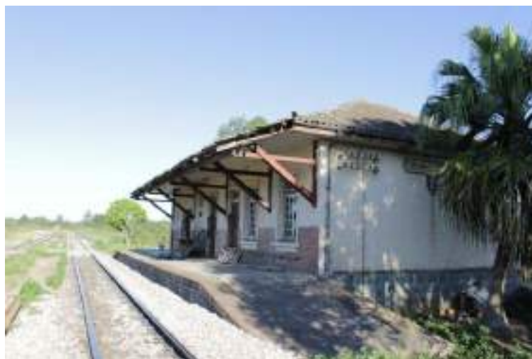
Figura 14: Estação Ferroviária de General Lúcio.
