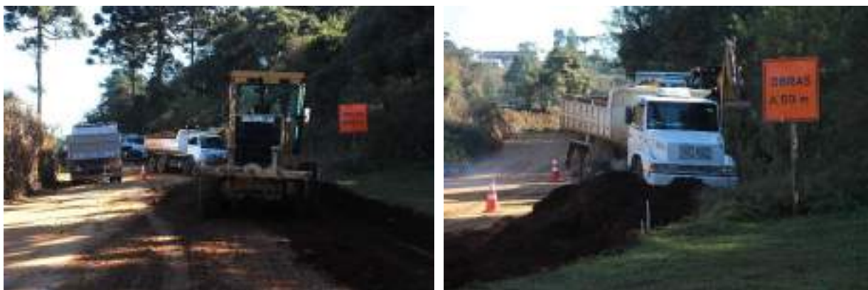
Figura 51: Obras na estrada Campo Redondo (julho de 2016).
