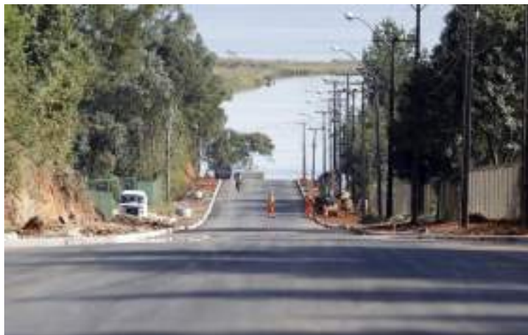
Figura 85: Obras do Programa Seu Bairro Novo finalizadas na Av. Centenário.
