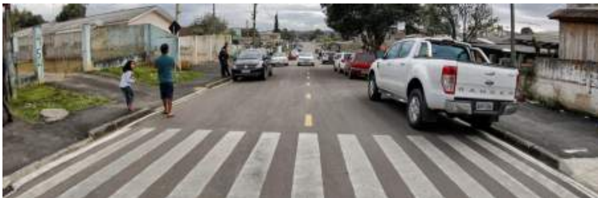
Figura 84: Obras do Programa Seu Bairro Novo finalizadas no bairro Boqueirão - Dalla Torre.
