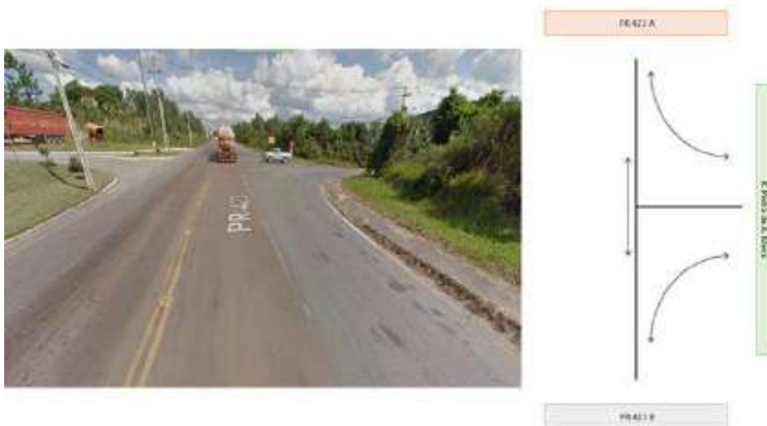
Figura 76: Interseção Rua Pedro de Alcântara Meira com a Rodovia PR-423.
