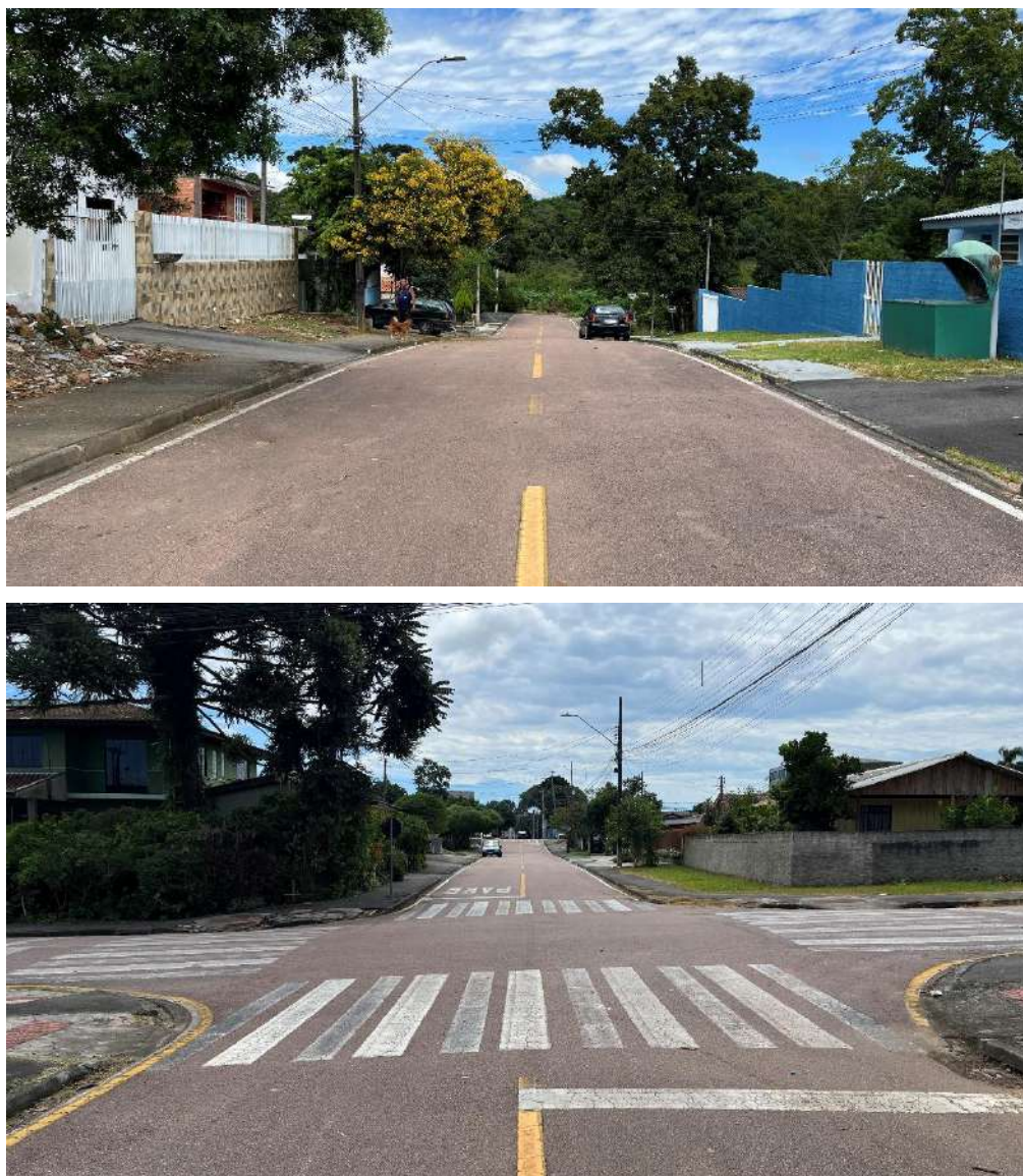
FIGURA 30 - FOTOS DA RUA ARISTIDES HITNER
