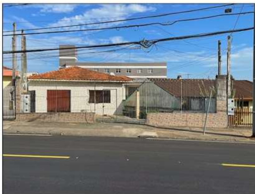
– Fachada da edificação presente na porção direita da frente da área de estudo. Foto sentido N-S.
