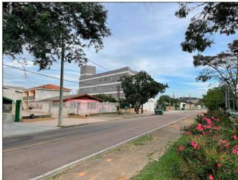
! – Foto tirada a partir da esquina da Rua Vergílio Alves Pinto com a Rua Alexandre Wisocki, mirando o Templo Religioso localizado no N.º 332. Foto sentido NO-SE.
