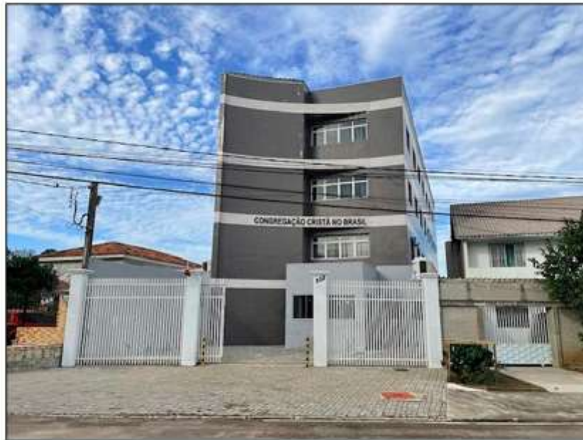
– Templo/edificação da Congregação Cristã no Brasil, com frente para a Rua Vergílio Alves Pinto, N.º 332. (Alvará Construção 124/05. Vistoria 310/11. Vide Anexo 04). Foto sentido O-E.
