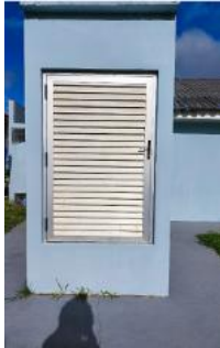
Local de armazenamento de lixo do grupo A e B
